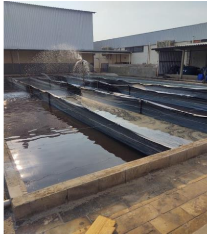
Figura 19 - Tanque de armazenamento de água tratada
