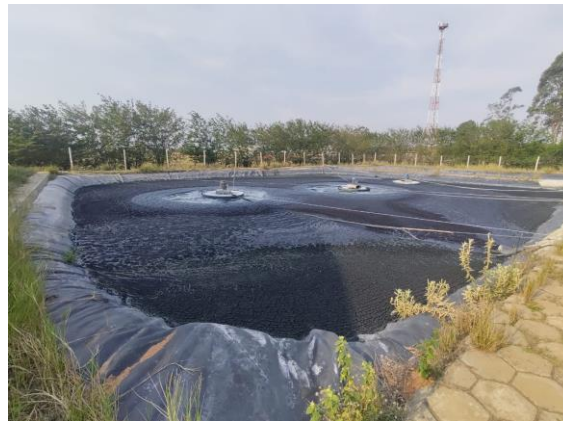
Figura 15 - Tanque de aeração
